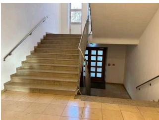
Treppe vom EG zum Speisesaal (UG)
