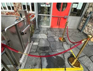
Weg zum Haupteingang (Teil 3): Hublift im Außenbereich
