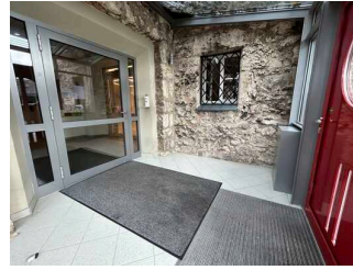
Windfangtür im Windfang
