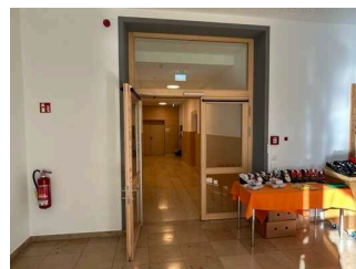
Zwei bauähnliche Flurtüren
