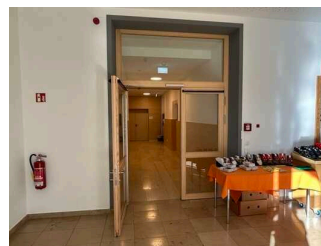
Zwei bauähnliche Flurtüren
