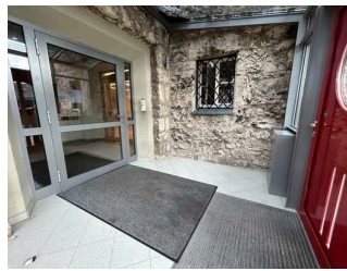
Windfangtür im Windfang
